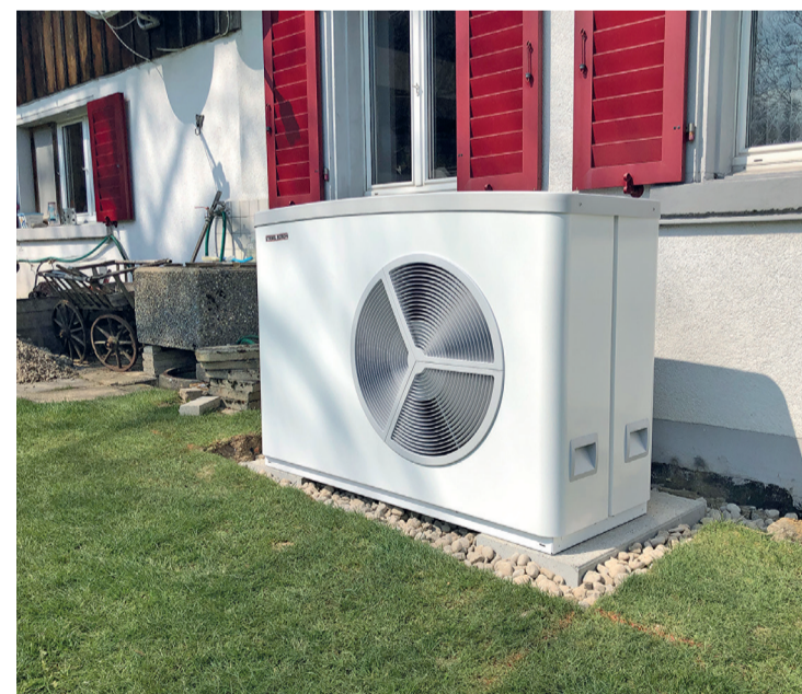
► Bei einer Luft-Wasser-Wärmepumpe wird ein kompaktes Aussenelement verbaut.
